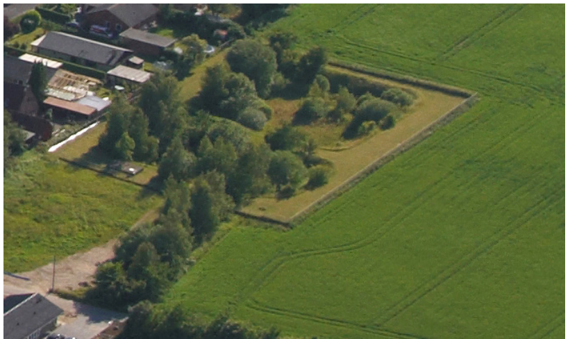
Spildevandsbassin med beplantning
